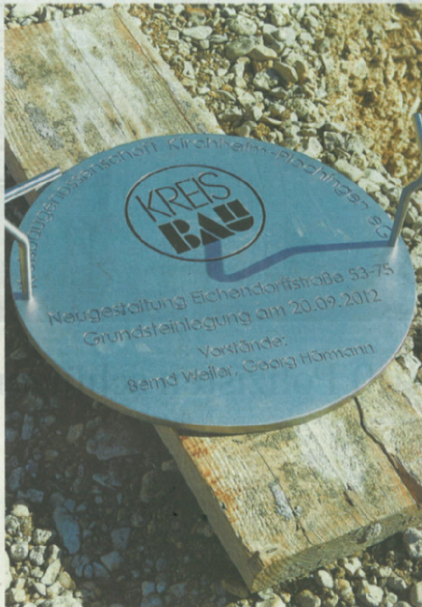
Der Deckel für den Grundstein zeigt deutlich, wer dort was baut.
