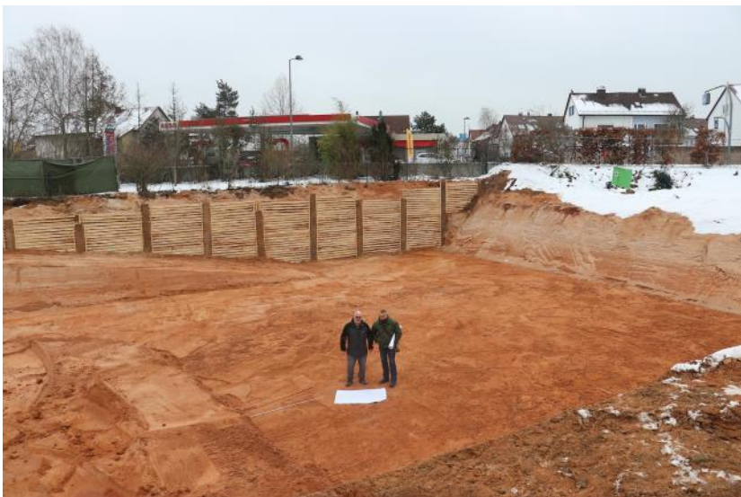
Blick in die Baugrube des Seniorenzentrums Gottfried Seiler. Foto: Bettina Nöth
