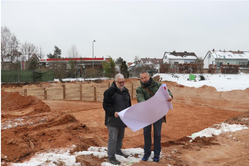
Baustellenbesichtigung: Werner Schmidt, Leiter des Altenhilfeverbundes Rummelsberg, und Christoph Arnold, zuständig für die Projektsteuerung, an der Baugrube für das Seniorenzentrum Gottfried Seiler. Foto: Bettina Nöth
